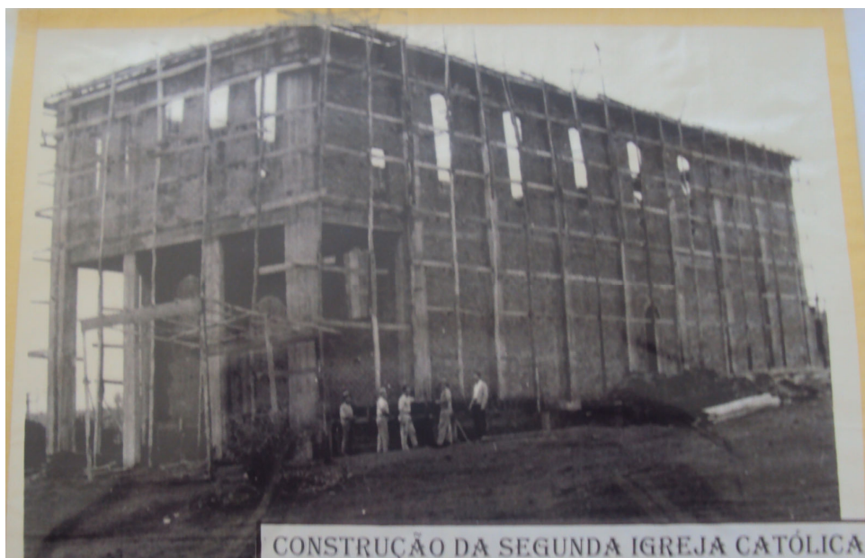
Fig. 5: Construção do novo prédio da Matriz de Cambira
