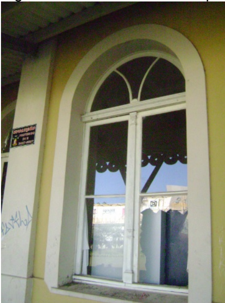
Figura 2 – Janela com vidro quebrado
