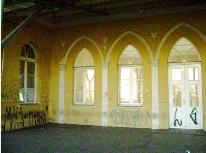
Figura 1 – Paredes danificadas com sinais de vandalismo
