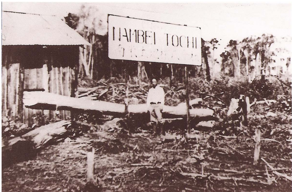
Foto n. 2: 1936:derrubada da mata e preparo do local para a construção do escritório da Companhia.
