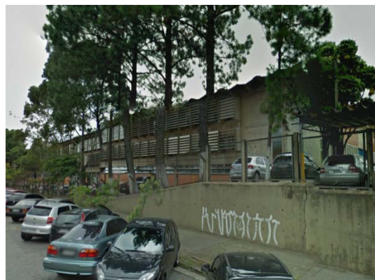
Figura 4: Foto da continuação do galpão visto pela pela Rua Agostinho Togneri
