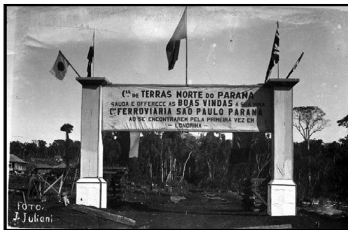
Figura 1: Portal de recepção à Inauguração do novo Ponto Ferroviário em Londrina. Autoria: José Juliani, 1935. Fonte: Acervo fotográfico digitalizado do CDPH-UEL.
