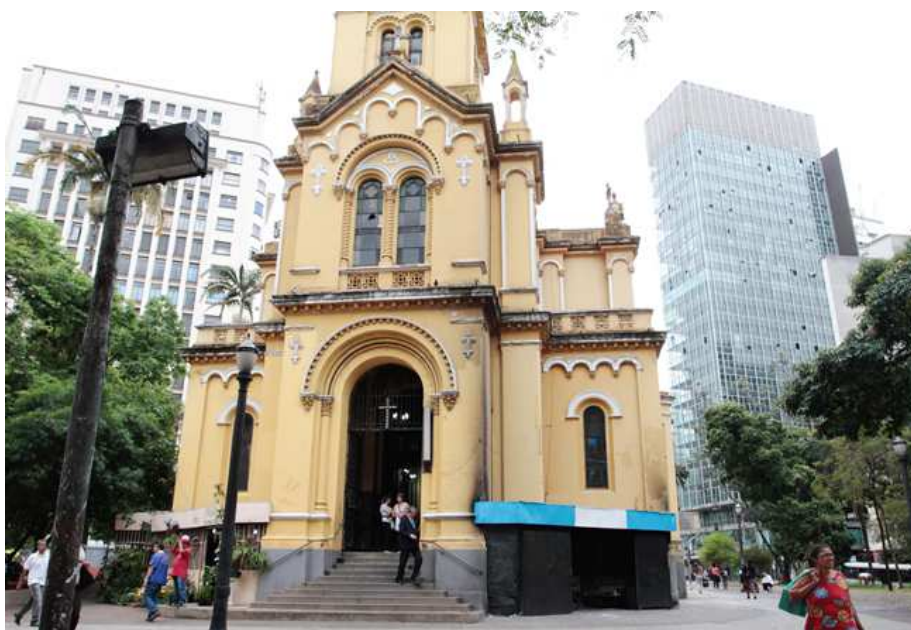
Figura 3: Fachada da igreja. Fotografia com autoria desconhecida (CANTO, 2011)
