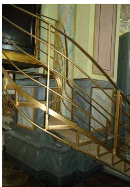
Figura 5: Detalhe coluna que sustenta a escada que leva ao púlpito do lado direito Autoria: Sandra C. A. Pelegrini
