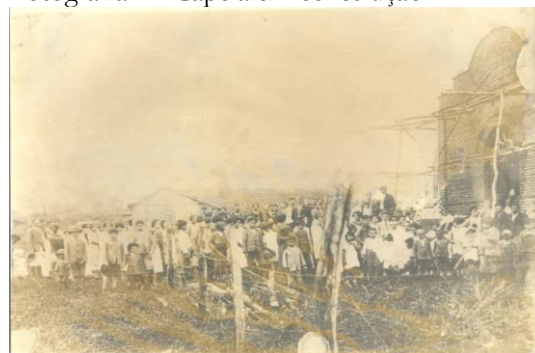
Fotografia 1 - Capela em construção
