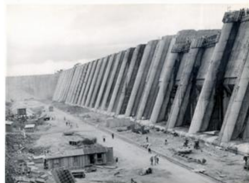
Figura 6 - Usina Hidrelétrica Souza Dias - Jupia
